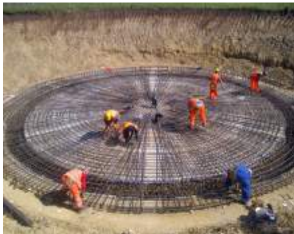
Ejecución de armadura
