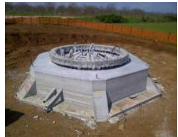
Resultado hormigonado de la losa superior
